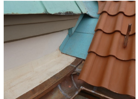
Die bogenförmige Kehlrinne wurde wieder mit patinierten Kupferblechen ausgeführt.
