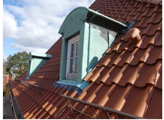
Die Dachanschlüsse wurden aus patinierten Kupferblechen ausgeführt. Dachseitige Kurvenkehlen wurden angearbeitet. Gaubenwangen wurden repariert.
