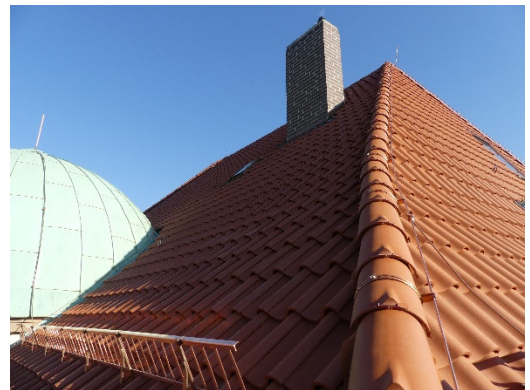
Erkennbar ist die neue Ziegeldachfläche, sowie montierte Schneefanggitter (Kupfer) im Traufbereich.
