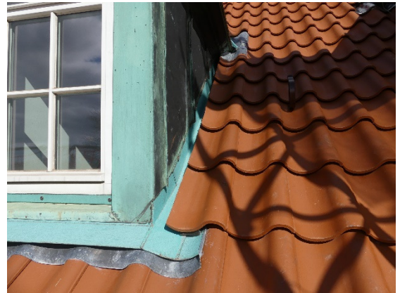
Erstellte seitliche Saumrinnen aus patinierten Kupferblechen, sowie vorderseitigen Walzbleianschluss mit oberhalb angeordneten Abdeckblech mit Rückkantung.
