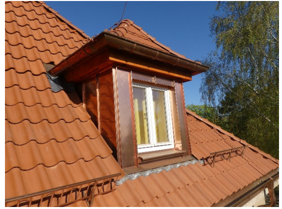
Die Walmdachgaube wurde entsprechend mit Biberschwanz-Dachziegeln (Kronendeckung) eingedeckt und mit Kupferblechscharen (Pass- und Sonderschare) verkleidet (Wangen und Ansichtsseite).
