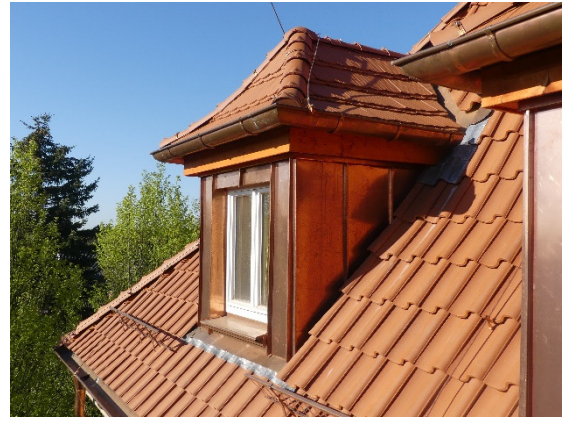
Die Walmdachgaube wurde grundlegend saniert, eingedeckt und neu verkleidet. Schadhafte Walmsparren wurden ausgetauscht, entsprechend profiliert und handwerklich eingefügt.
