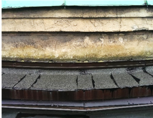
Gesimswandfläche unterhalb der Kuppel. Die Putzflächen, Dachabdichtung und Traufbleche mit Vorhangrinnen wiesen diverse Beschädigungen auf.
