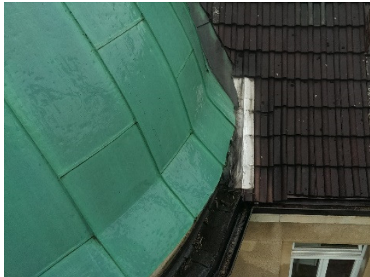
Übergang Kehlrinne zur Traufe (Bereich Kuppel). Nordseite der Dachfläche.
