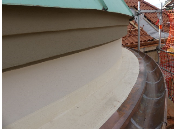
Ausgeführte Putz- und Malerarbeiten. Es wurden gezogene Traufbleche und wieder eine halbkreisförmige segmentartige Vorhangrinne verbaut.
