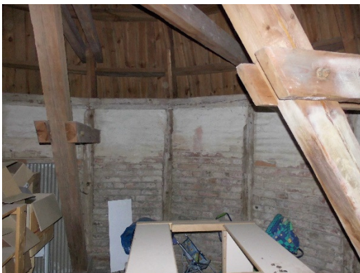
Massiv durchfeuchtetes Kniestock-mauerwerk unterhalb der Kuppel. Die Fachwerkkonstruktion sowie angrenzende Deckenbalken wiesen massive Beschädigungen auf.
