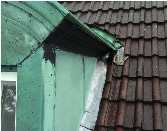
Prov. Abdichtung im Bereich der Tonnendachgaube (Westseite).
