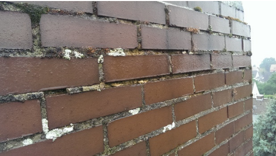
Schadhafter Schornsteinkopf im Bereich der nördlichen Dachfläche.
