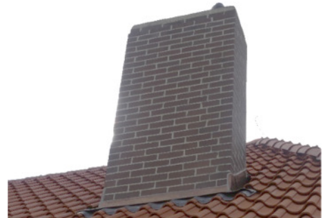
Sanierter Schornsteinkopf mit Einfassung in Kupfer-Klassik Blechen.
