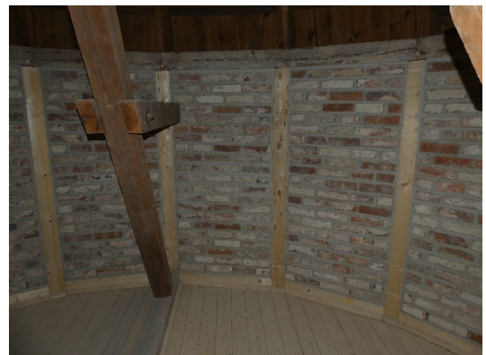
Erneuerung der Fachwerkkonstruktion mit artgleichen Holz sowie wiederverwendeten und gereinigten Backsteinen zum Ausmauern der Gefache. Ertüchtigung der Deckenkonstruktion.
